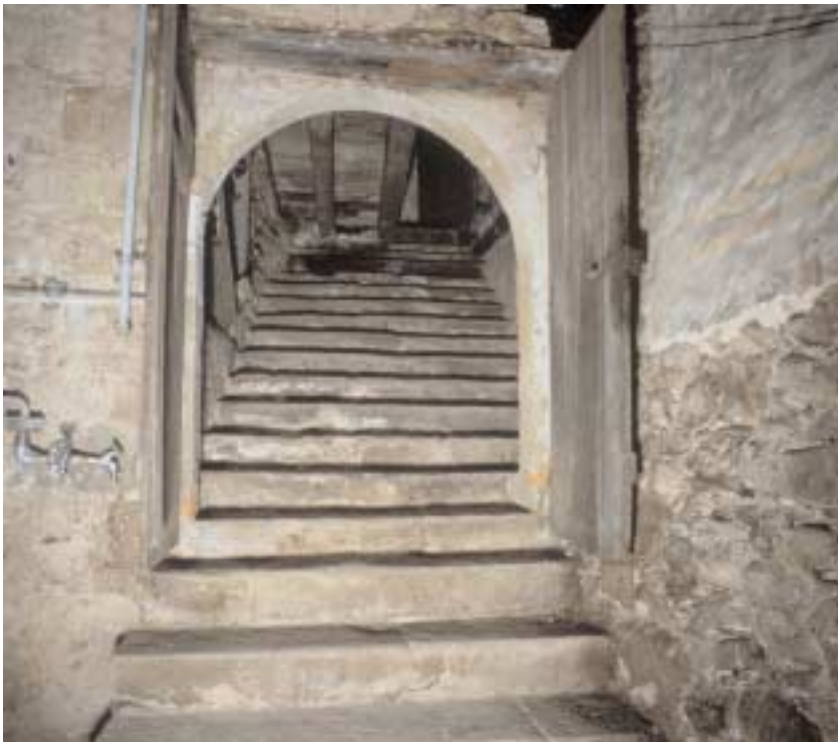
Das Haus in Winterthur an der Oberen Kirchgasse 18 wurde gemäss dendrochronologischen Untersuchungen im Jahr 1311 unterkellert. Die ansehnliche Breite des Kellerabgangs von 2,2 Meter erlaubte unter anderem auch die Einlagerung von Weinfässern im Keller. Kantonsarchäologie Zürich.
