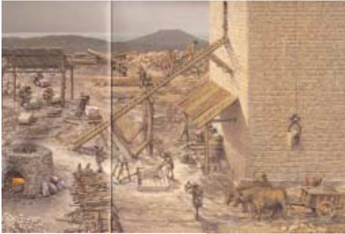
Baustelle auf einer Burg. Im Hintergrund sind Steinmetze und Zimmermänner zu sehen. Im Vordergrund erkennt man das Kalkbrennen, Mörtelmischen sowie das Hochziehen von Quadern mit einem einfachen Kranen. H. BOXLER, Burgenland Schweiz, Bau und Alltag (Solothurn 1990).
